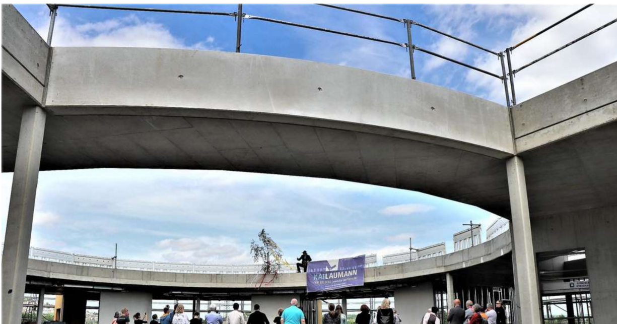
Schon der Rohbau sorgt für neugierige Blicke. © Schäfer
